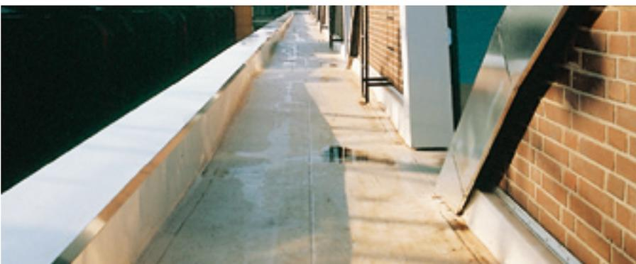
Pressblanke, farbbeschichtete oder eloxierte Serienprofile – passgerecht für geradlinige und abgewinkelte oder gerundete Dachränder.
